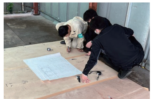
施工を専門に手がける(株)丹青TDCとともに実施した『墨だし研修』のようす。グループ会社で連携しながら「人材」の育成を進める
