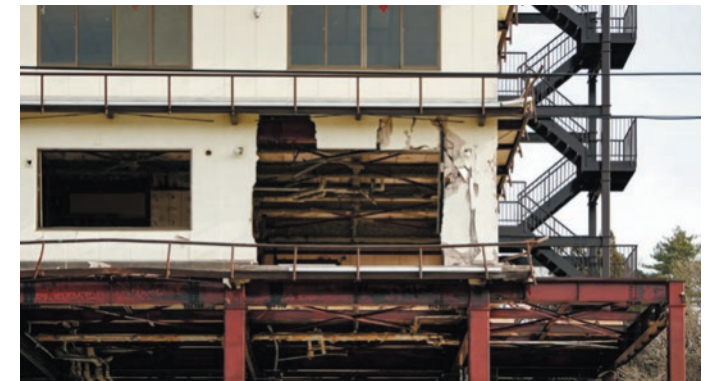
破損部分を保存
