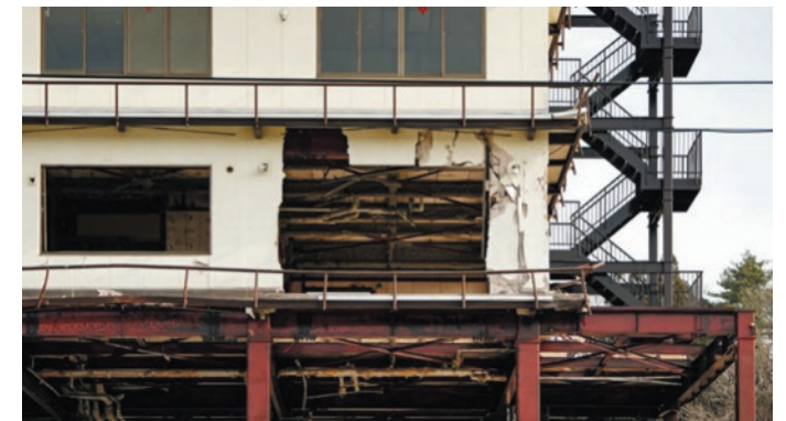
破損部分を保存
